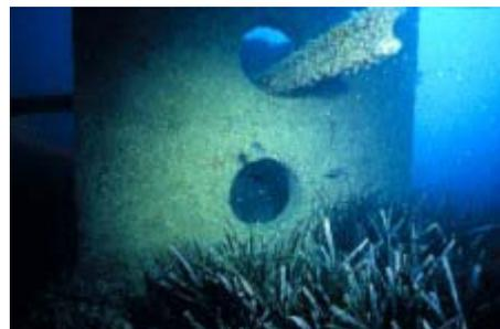
**Foto 2.** Bloque disuasivo del arrecife artificial de El Campello (Alicante) protegiendo la pradera de Posidonia, a -15 m de profundidad. Cubo alveolar de 2 m de lado y 7.9 tm de peso (foto de P. Sánchez Jérez).
